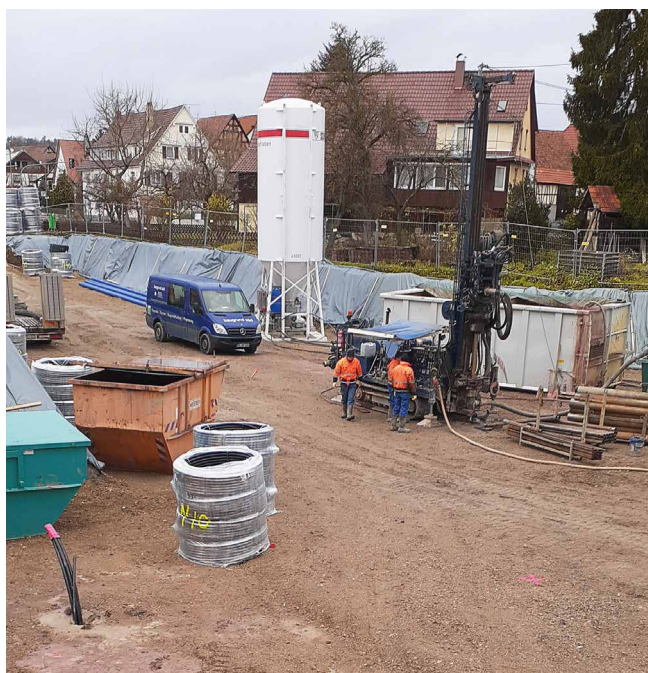
Abb. 3: Bohrung der Erdsonden
