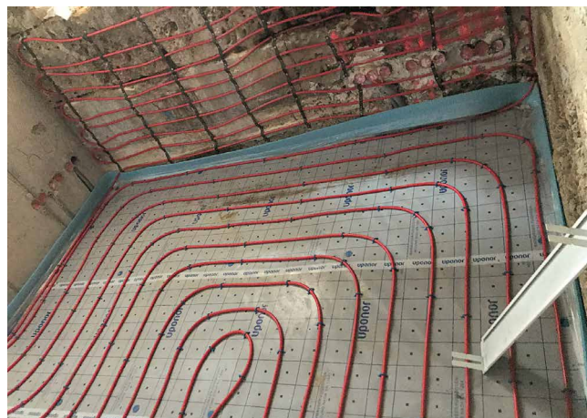
Abb. 5: Fußboden- bzw. Wandheizung
