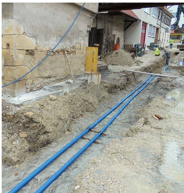
Abb. 4: Verlegung einer Soleleitung
